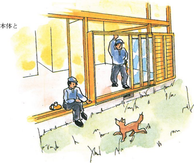
「全開はさもちいねえー」「戸車もドライバーで簡単に調整できるわけだ」「けっこう！」
